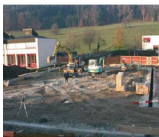
12. März 2005 offene Baustelle
