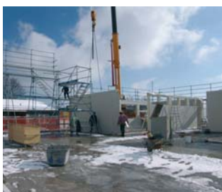
17. Februar 2005 Beginn der Elementmontage
