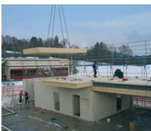
17. Februar 2005 Beginn der Elementmontage
